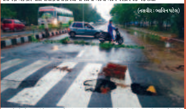
મેઘવિધો મન મુકીને વરસાદ શહેરમાં જળબંબાકારની સ્થિતિ વચ્ચે વરસાદી સમસ્યાઓ ઉભરાઈ રહી છે. સતત વરસાદ વરસાદના લીધે શહેરના 'ગ'-૫ પાસે માર્ગ વચાળે મોટામોટા ભૂવો અસ્તિત્વમાં આવ્યો છે. ભયજનક ભૂવાથી બચવા દરમિયાન વાહનોની અવરજવર પણ વન-વે કરી દેવાઈ હતી. માર્ગની એકબાજુએ પણ માટીપોલાણ થતા મોટા ગાબડા પણ સર્જાયું છે. તંત્રએ અકસ્માત નિવારણ તંત્ર સમારકામ હાથ ધરવાની તાતિ જરૂરિયાત ઉભી થઈ છે.
