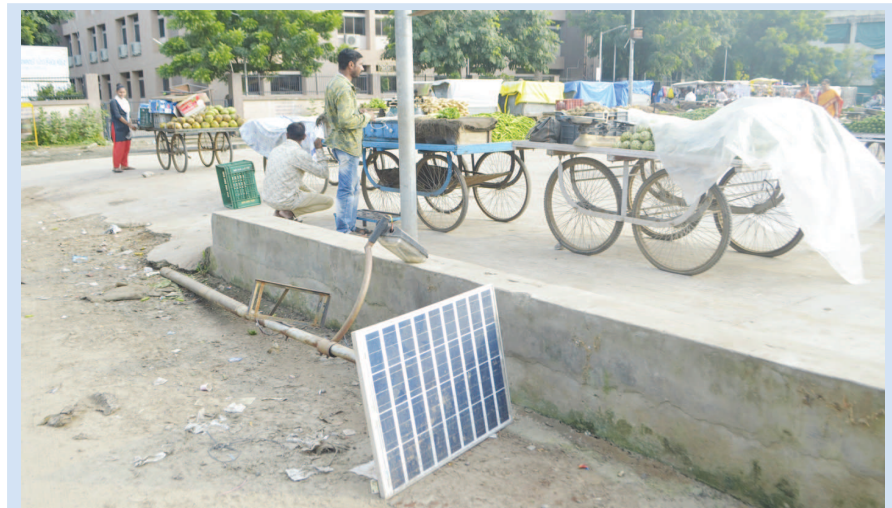
સેક્ટર-૭ શાકમર્કેટમાં છેલ્લા ઘણા સમયથી સોલાર પેનલનો થાંભલો નીચે પડી ગયો છે. સોલાર પેનલની બેટરી તો છેલ્લા ઘણા સમયથી ચોરાઈ ગઈ છે. થાંભલો પણ ચોરી થવાની સંભાવના છે.
